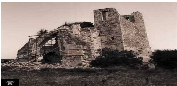
1973 Chantier de restauration.
